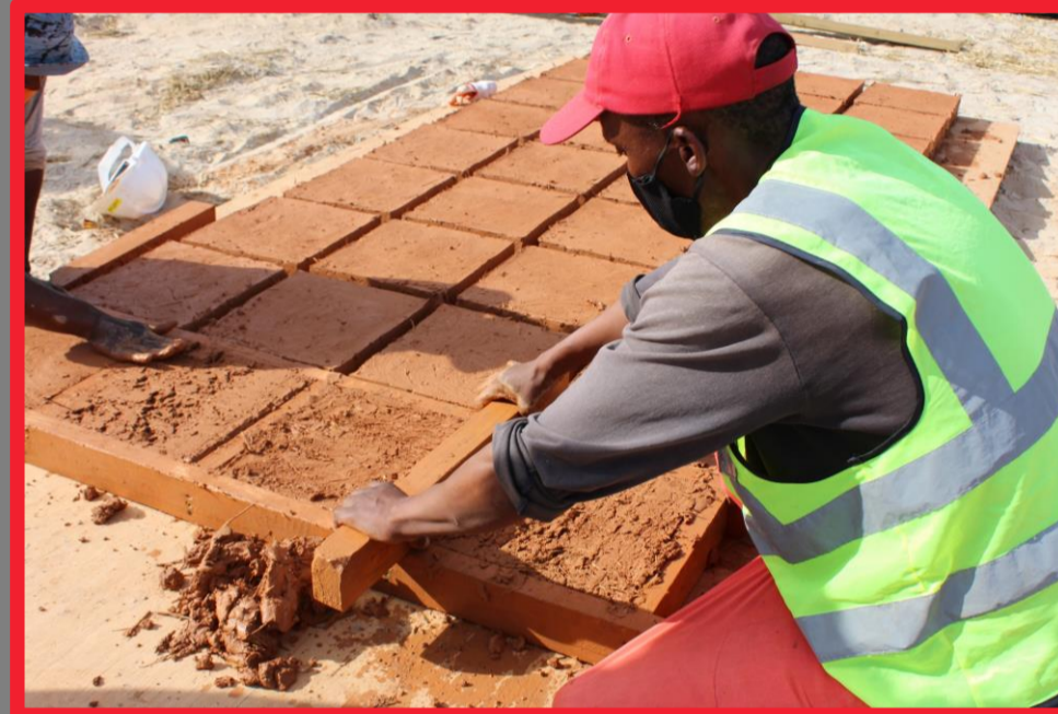
Sicherstellen, dass die Formen richtig gefüllt sind
