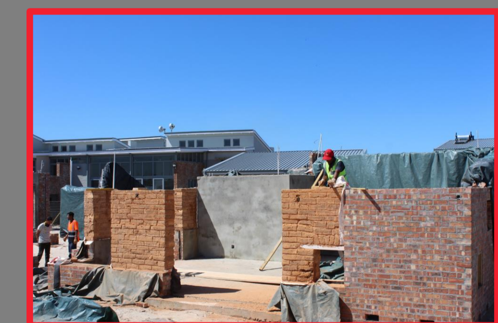
Außenwände im Bau
