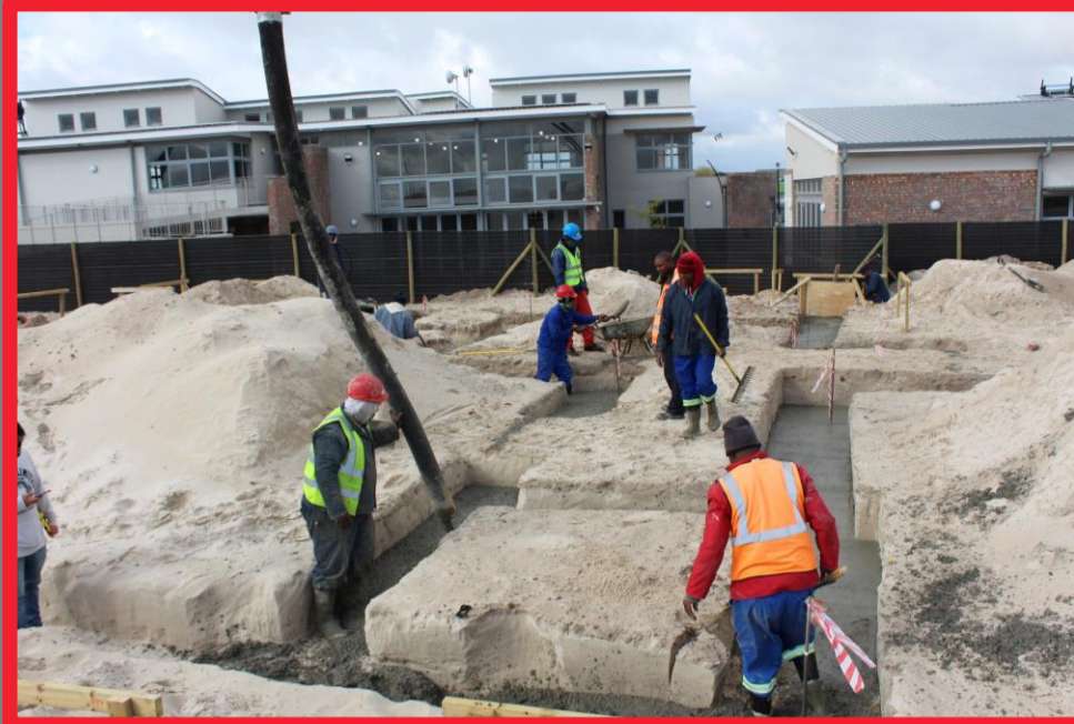
Gießen der Betonfundamente
