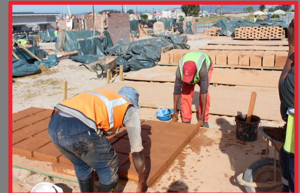
Freigeben der Ziegel
