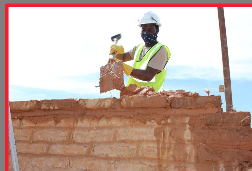
Nivellierung von Ziegeln
