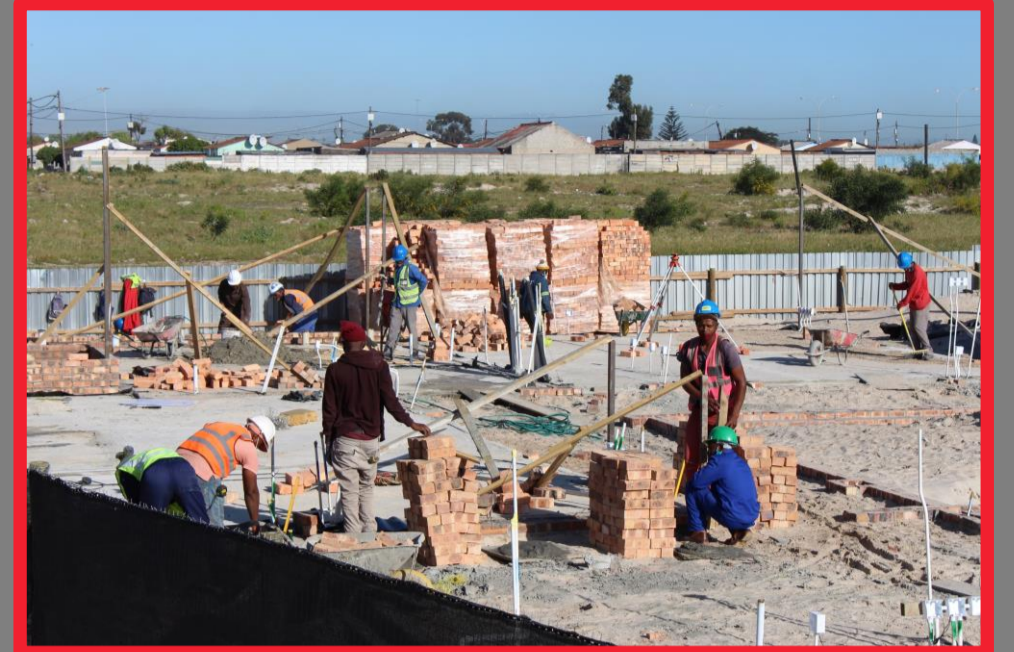
Beginn des Baus der Innenwände
