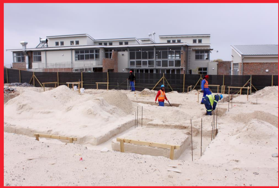
Anzeichnen und Ausheben von Fundamenten
